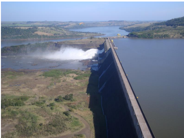
Central Hidroeléctrica Salto Caxias ubicada en el río Iguazu al sur de Brasil en operación con las compuertas abiertas para la generación de energía. / Imagen: Victor Carvalho - Flickr
